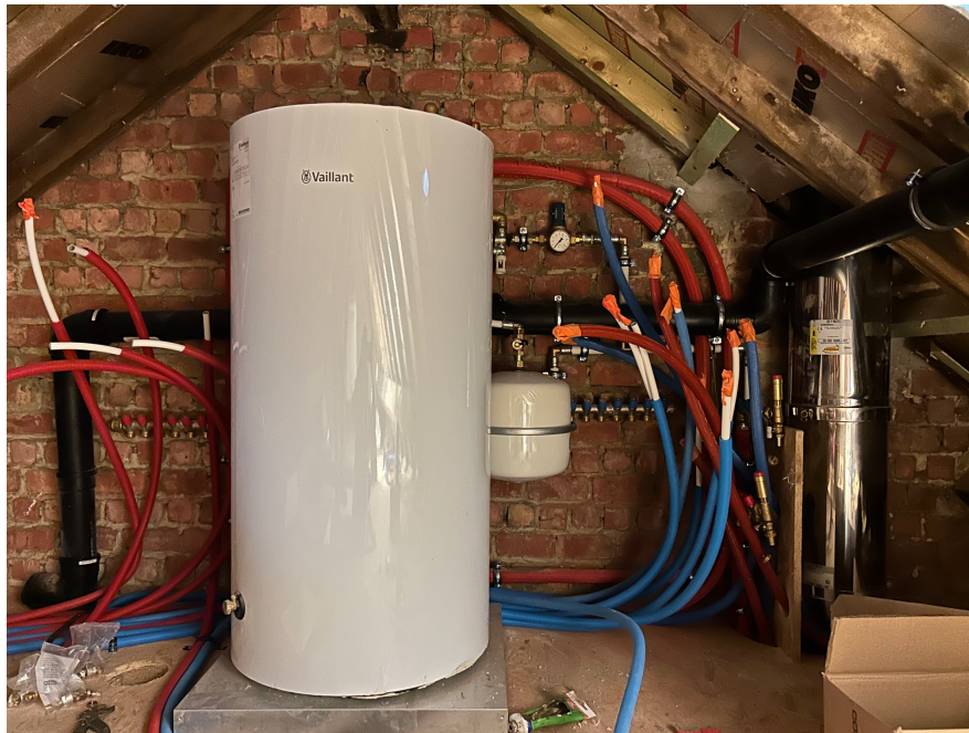
Photo 16 : Nouveau boiler pour logement 4 – TRAVAUX EN COURS
