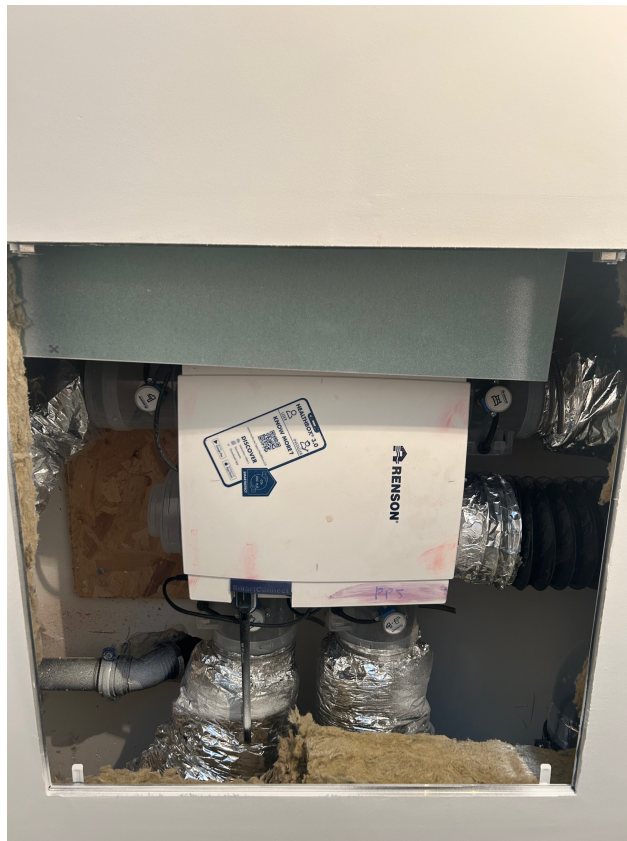
Photo 17 : Système de ventilation simple flux pour Logement 1, 2 et 3 – TRAVAUX EN COURS
