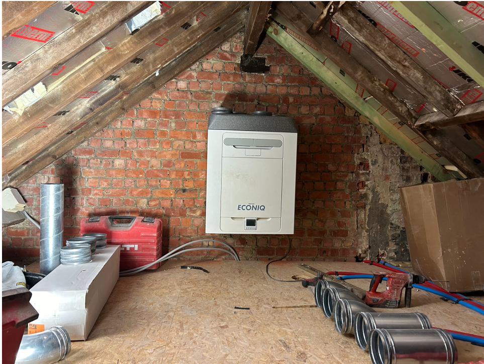
Photo 15 : Nouveau système de ventilation double flux pour logement 4– TRAVAUX EN COURS
